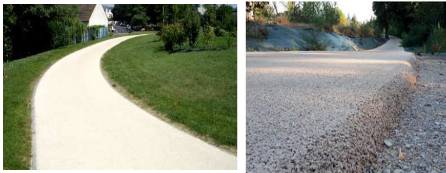
Exemple stabilisé calcaire / revêtement perméable DECOVIA / QUALIRAIN
