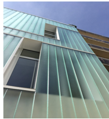
Traitement fermeture façade des locaux vélo de type reglite
