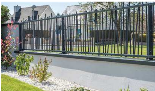
Clôture barreaudage sur muret
