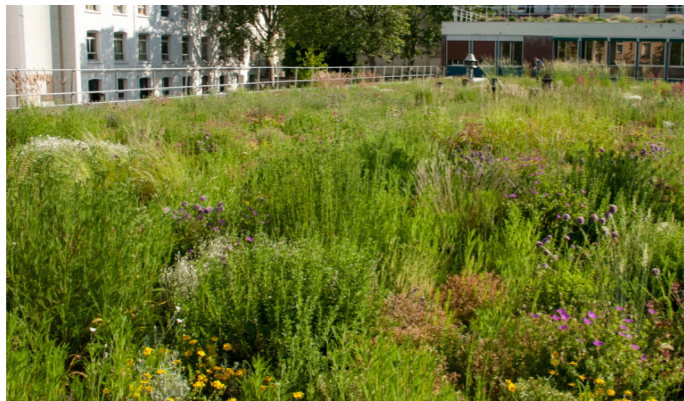
Toitures végétalisées à fortes épaisseurs de terre
